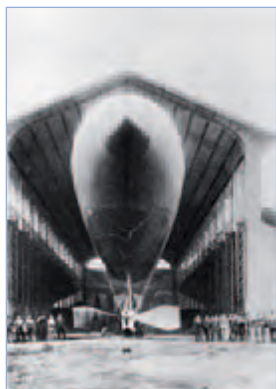
Figura 1. Pionero por excelencia: aeronave “La France”, de 1884, la primera en ser totalmente dirigible y funcionar eléctricamente, aparte de suponer la primera aplicación de la pila de flujo redox del mundo. (Imagen: Wikimedia Commons/Foto de 1885, 2001 National Air and Space Museum, Smithsonian Institution)
