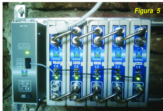
Cabecera real de antena colectiva para la recepción simultánea de la televisión por satélite y terrestre.
